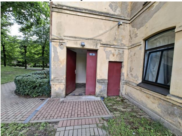
Skats uz kāpņu telpu
